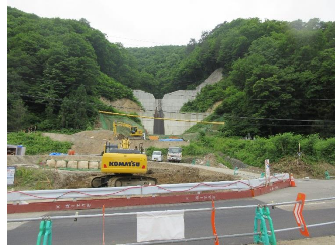
南会津町内川地内
