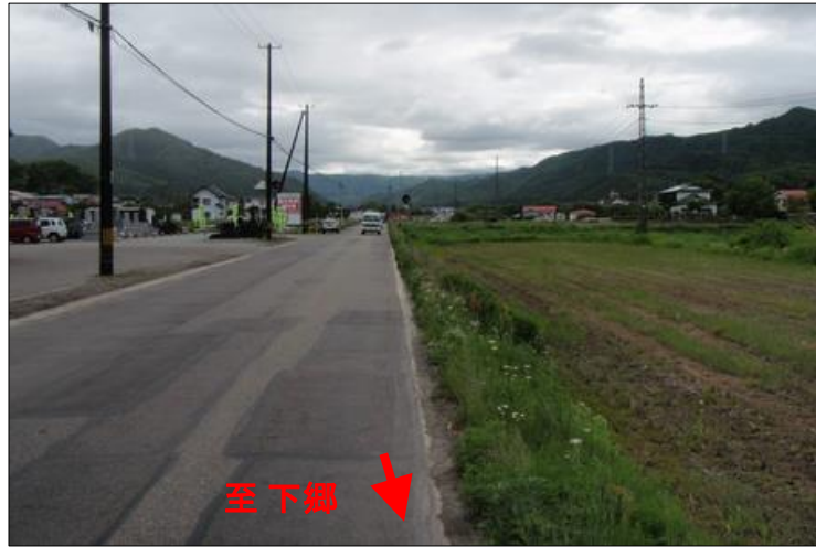
工事着手前 (平成22年度)
