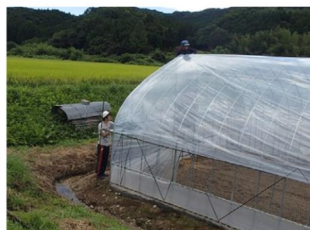
↑ ビニールがけ作業
