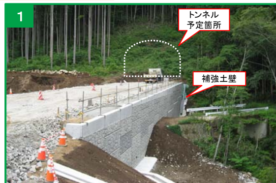
補強土壁の完成状況 (平成30年7月撮影)
