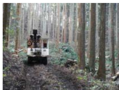
作業路を利用した間伐材の搬出
