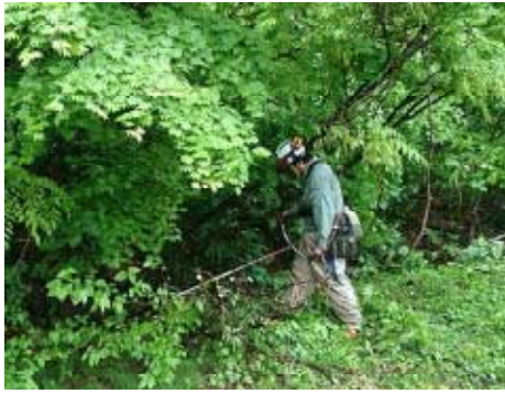
緩衝帯整備の様子
