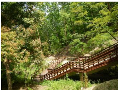
木製階段の設置（福島市）
