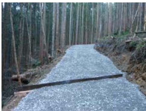
作業道の開設状況
