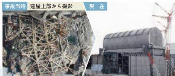
＜参考＞ 3号機の状況(左：事故当時、右：現在)
