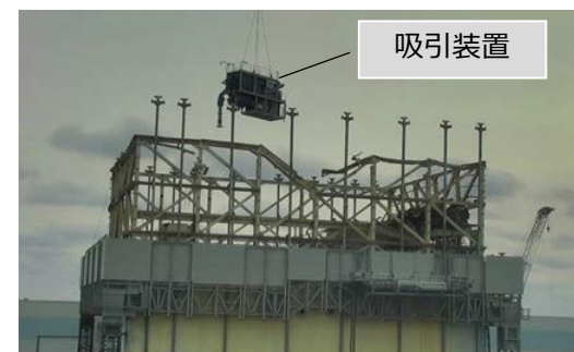
ガレキ撤去の作業状況（2018年1月22日）
