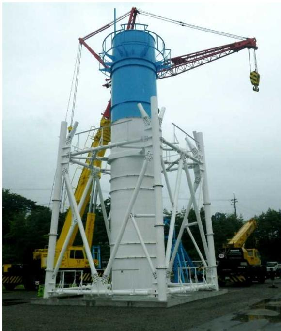
排気筒模擬体 設置作業状況
