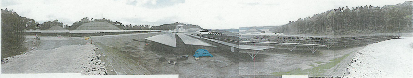
全景(E)－西側管理用通路より
