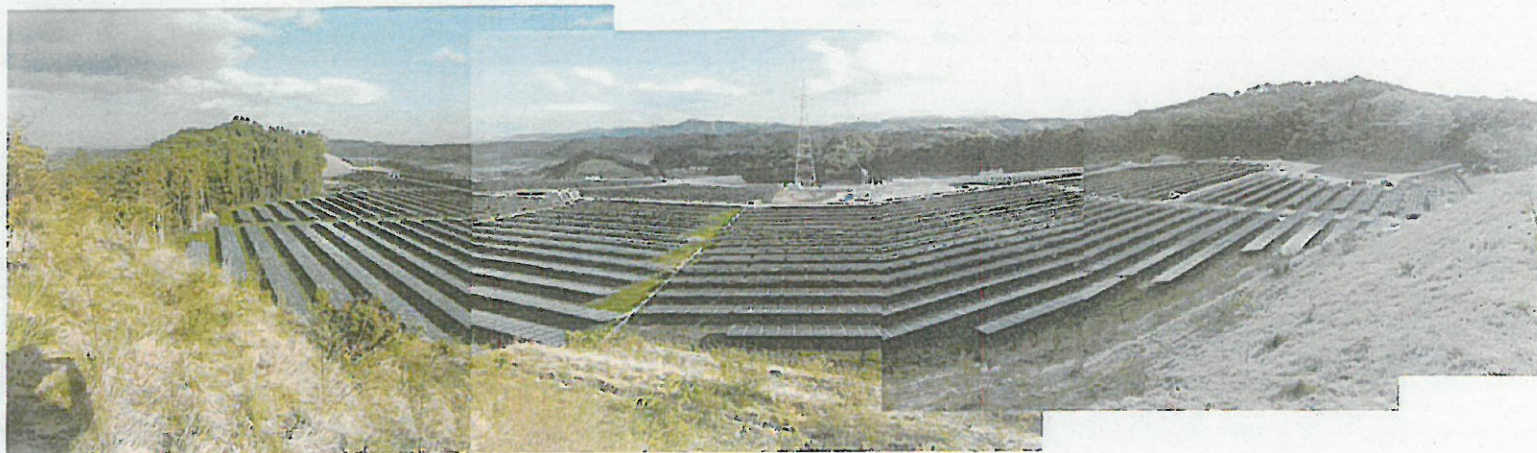
全景(F)－北鉄塔付近より
