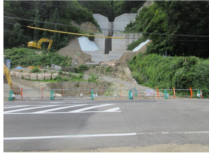
南会津町内川地内
