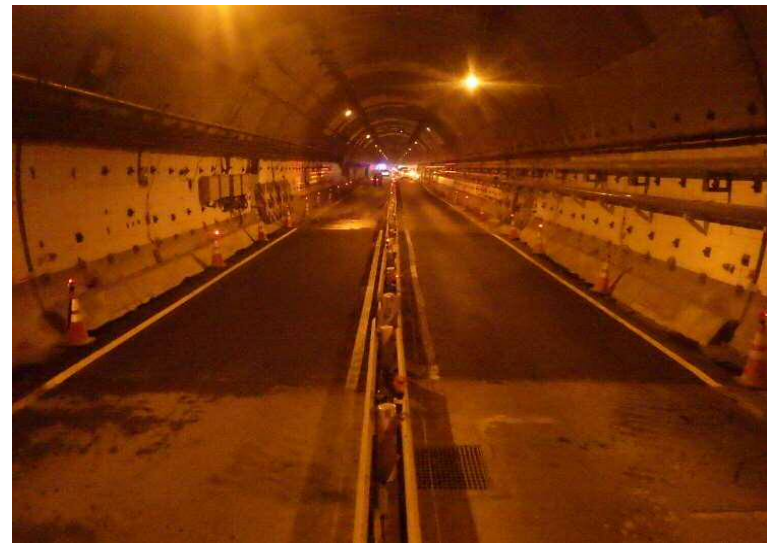
舗装を行い、交通規制を解除しました。 施工区間がスロープになっていますので、スピードに注意して、運転をお願いします。
