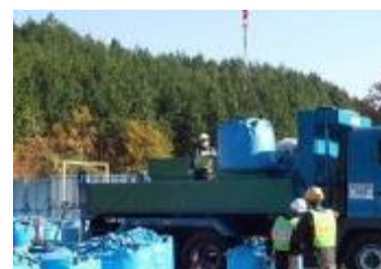
除去土壌等の車両積込状況
