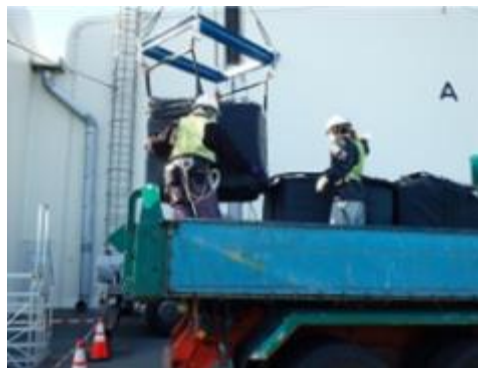
輸送車両への廃棄物積込状況
