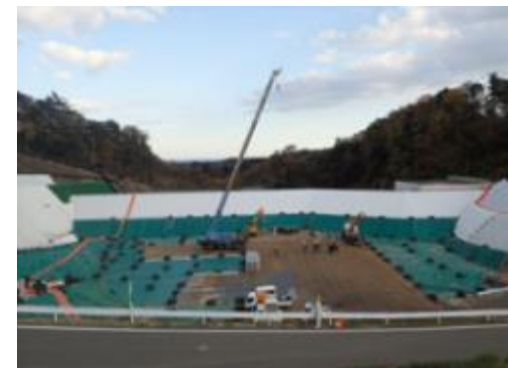
埋立処分施設の状況
