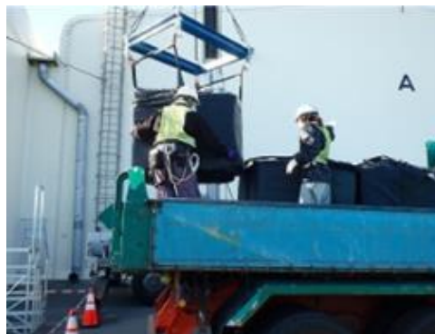
輸送車両への廃棄物積込状況
