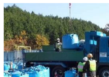
除去土壌等の車両積込状況
