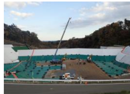
埋立処分施設の状況
