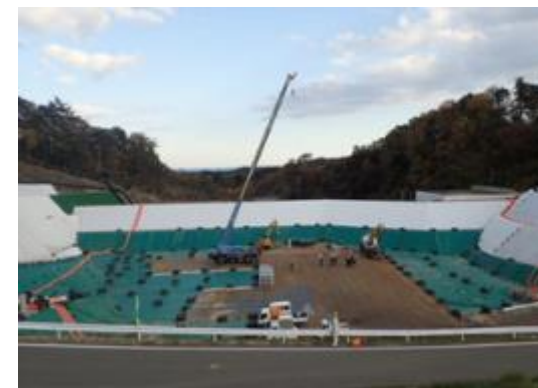
埋立処分施設の状況
