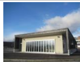
猪苗代水環境センター
