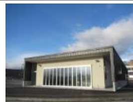
猪苗代水環境センター
