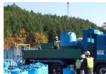
除去土壌等の車両積込状況
