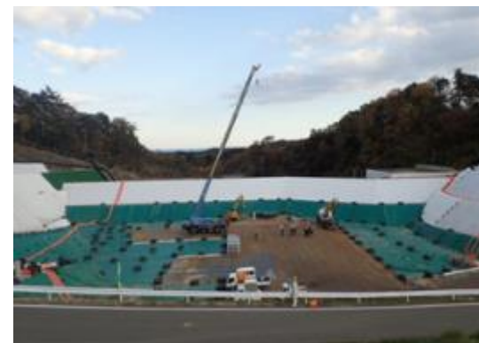
埋立処分施設の状況
