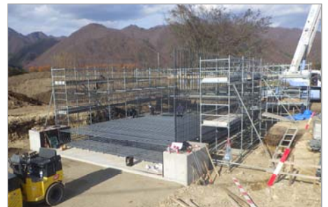
【写真-2】工事進捗状況
