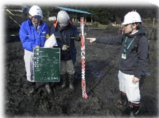
【工事現場の確認立会の様子】
