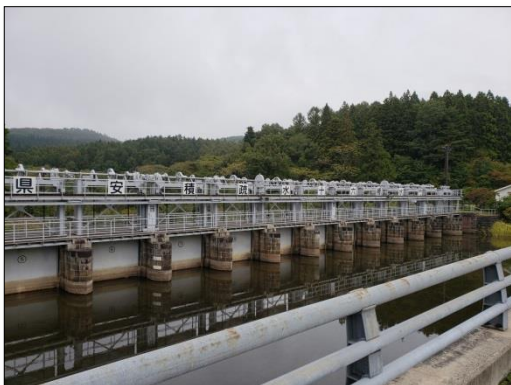
【安積疎水十六橋水門】
