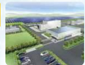
再エネ由来大規模水素製造実証拠点 (イメージ図) (出典 東芝エネルギーシステムズ)
