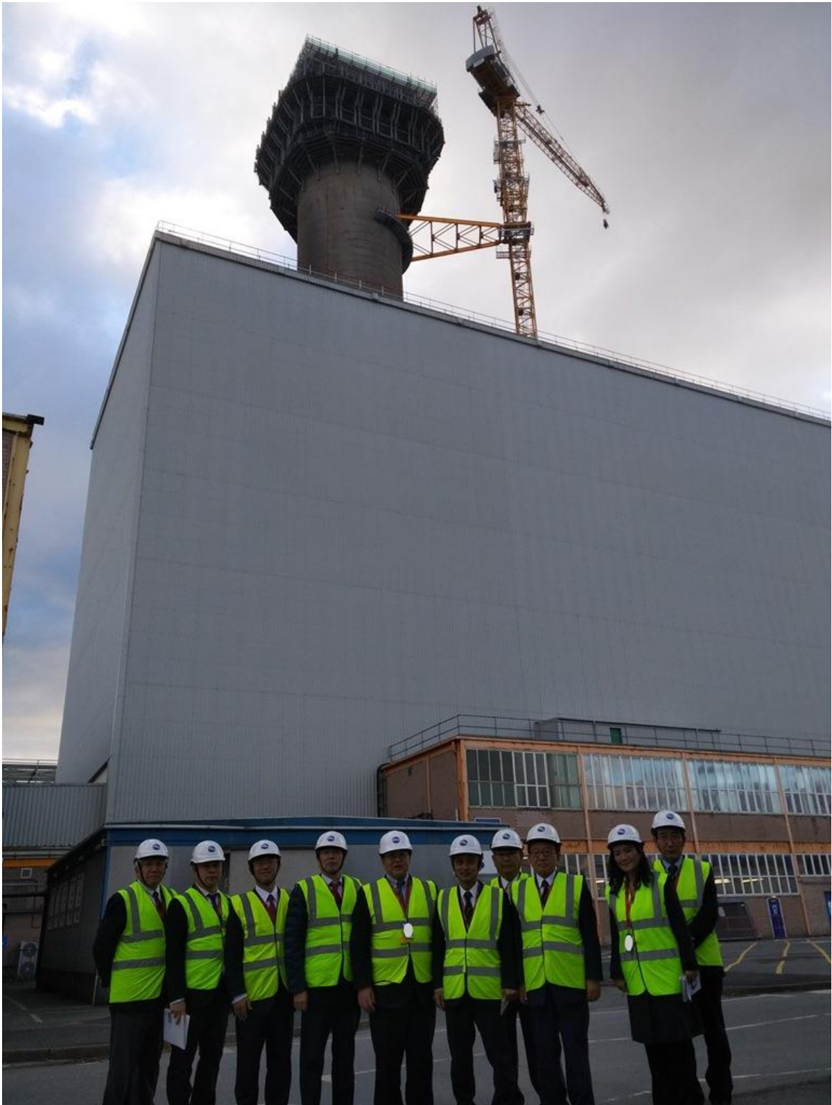
【解体作業中の排気塔の前にて】
