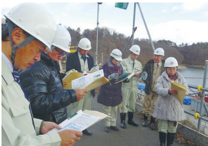
千五沢ダムを調査する土木委員会
