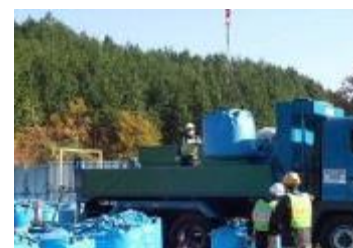
除去土壌等の車両積込状況
