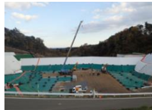
埋立処分施設の状況
