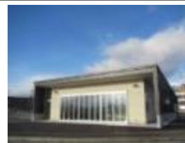
猪苗代水環境センター
