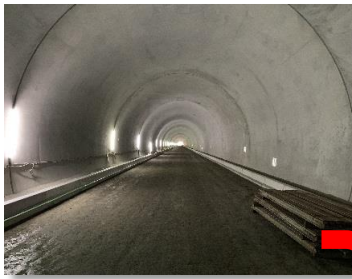
1 トンネル内の舗装(コンクリート舗装)が完成しました。
