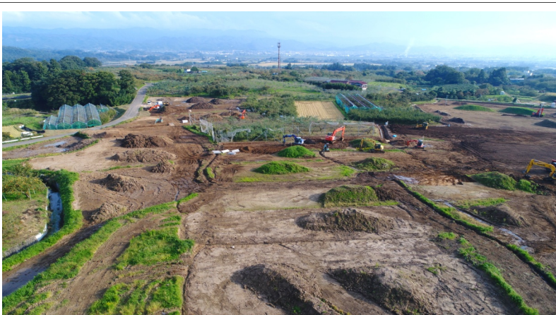
小さい未整備田を営農効率の良い大区画へ工事中
