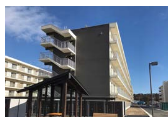
復興公営住宅（南相馬市）
