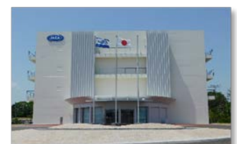
大熊分析・研究センター 施設管理棟(大熊町)
