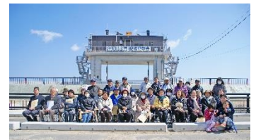
《ゲート閉鎖の多重化機能を有する弁天川水門》
