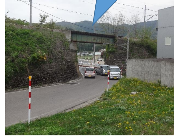
南会津町田島地内
