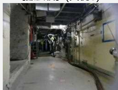
【撤去後】(矢視C)
