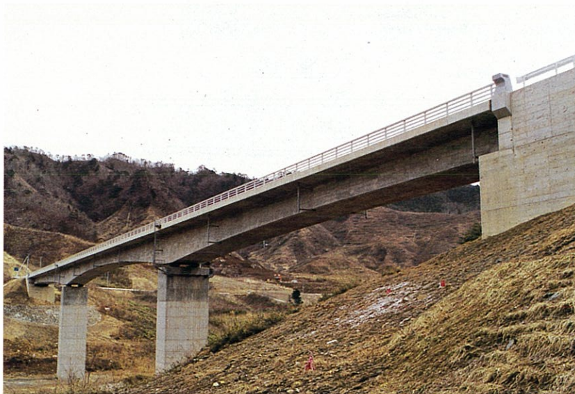
松ヶ平橋はデイビダーク工法により施工された。
