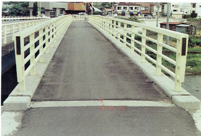
本橋の曲線橋に合わせ、1 スパンを斜橋にしている。
