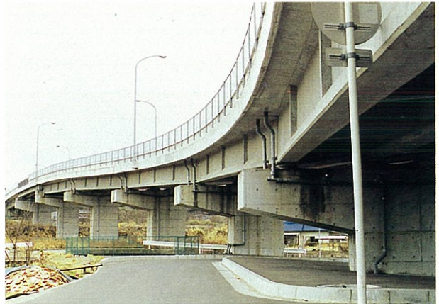
曲線部もPC桁で配置され、張出しで調節されている。
