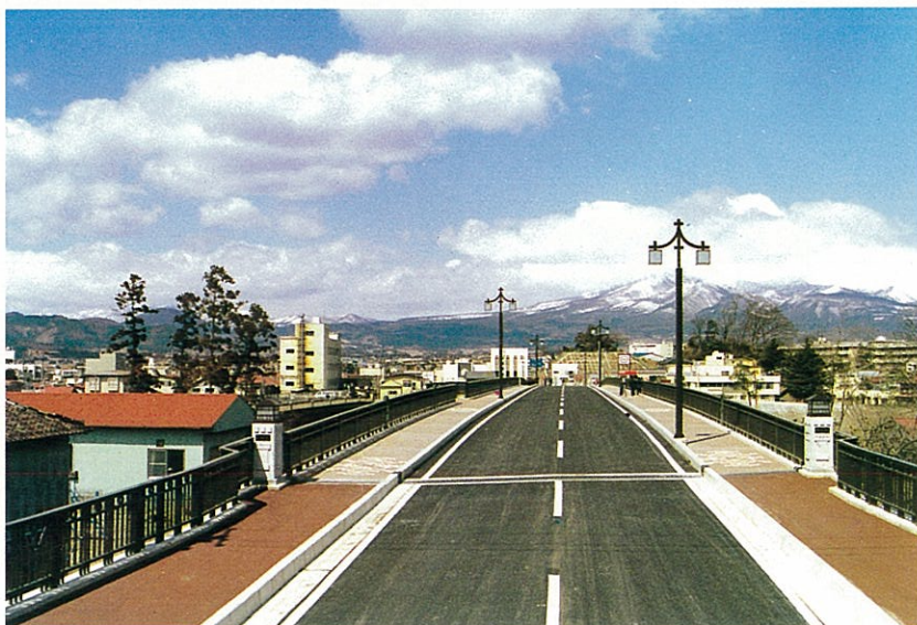
(写真-5) 新しくなった昭代橋
