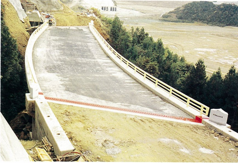
大内ダム付替道路により完成した大内1号橋
