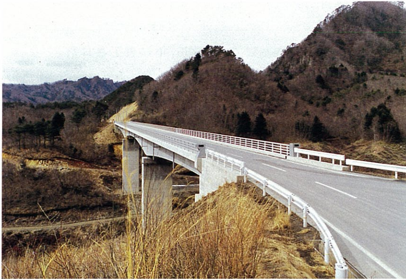
変断面のPC箱桁が地形にマッチして美しい。 昭和64年頃は湛水が開始される。
