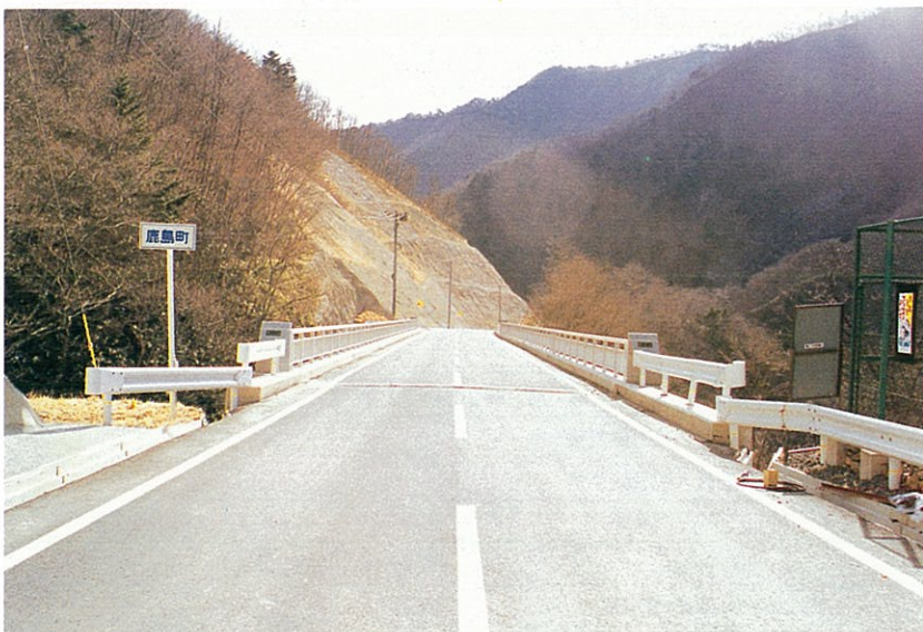
規格改良された付替道路。
