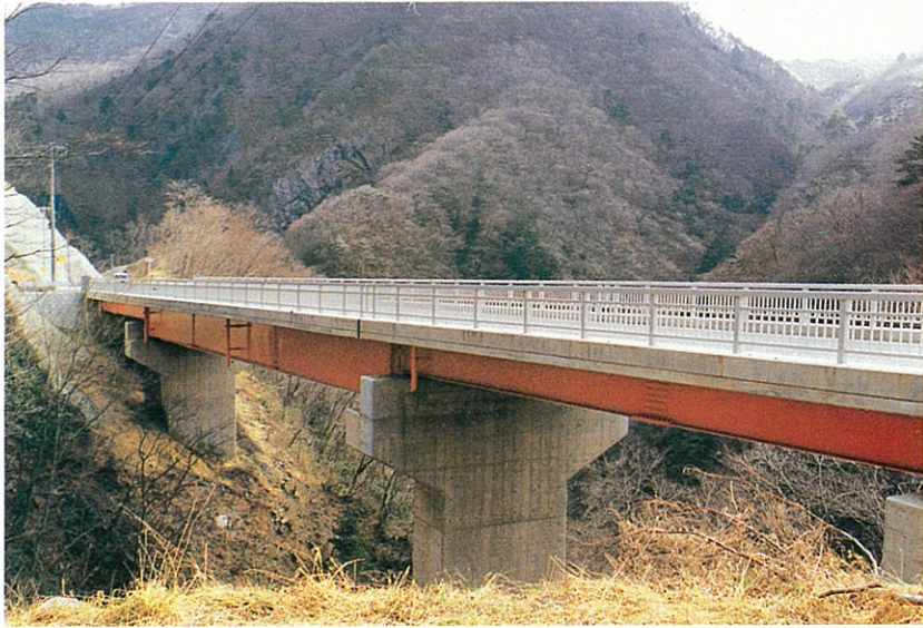
鈹桁とH型鋼桁の組合せとなっており、沢部をさけて橋脚を施工している。
