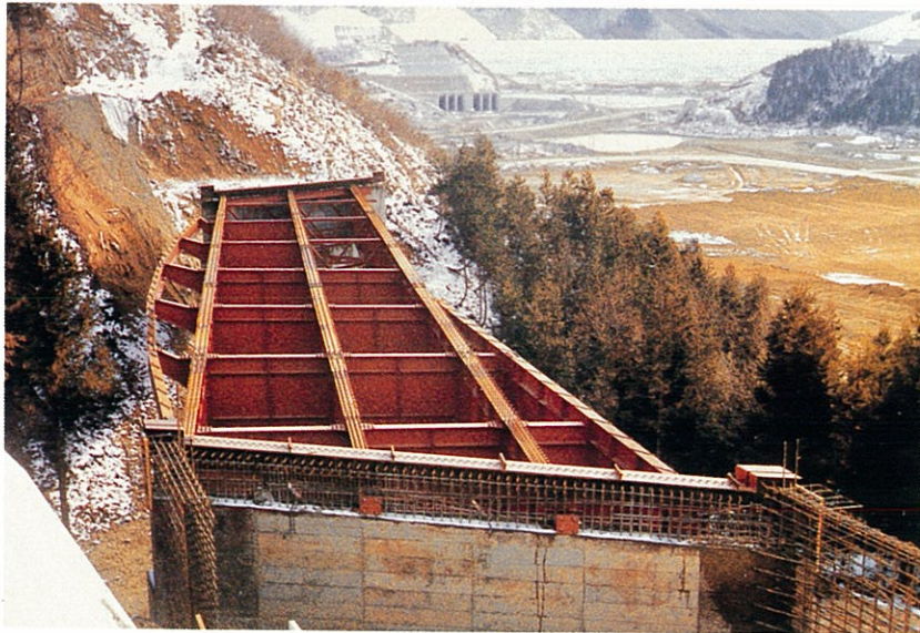
曲線橋で、桁の配置に苦心されている。
