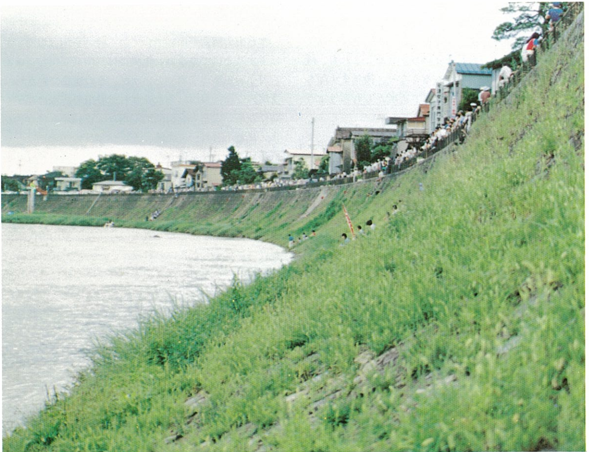
昭和6年(1931年)完成の万里の長城を思わせるような石垣積みの護岸。現在も昔の姿のままである。
