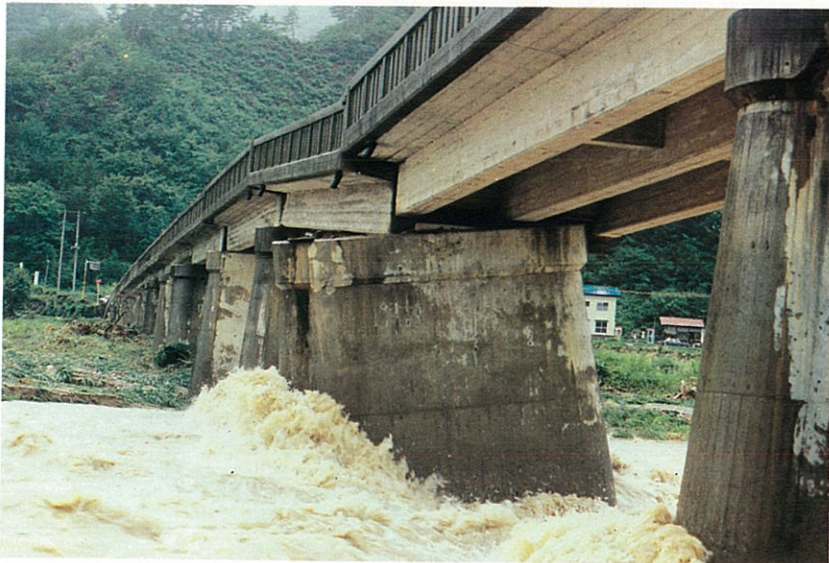
昭和56年夏、台風15号の直撃を受けて落橋する旧橋。
