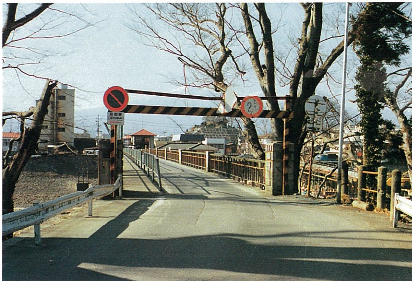
(写真-4) 2トン制限の老朽橋となった現橋
