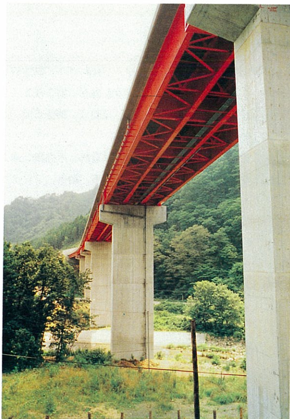
◀ 堰守橋 せまもり 国道114号 \ell 296.0m w 6.0/9.25m 3径間十二径間連続非合成鋼桁 (S.55)
