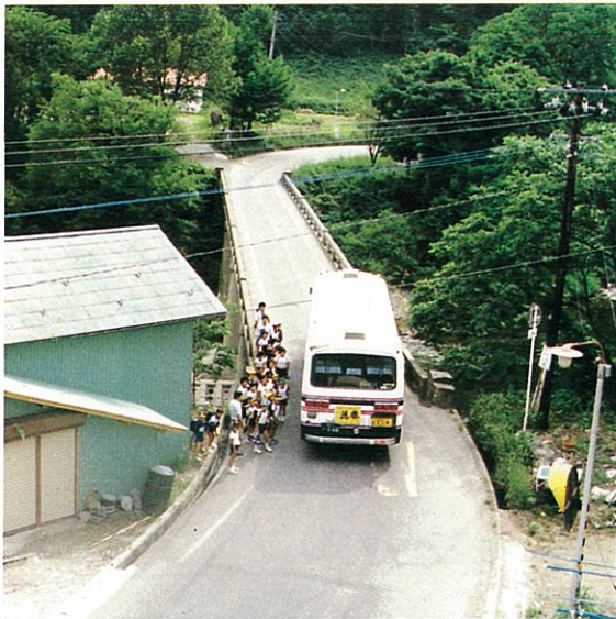
線形も悪く幅員の狭い旧橋。大正15年架設の老朽橋だが、館岩村に管理替えされ今後も村道橋として活躍する。
