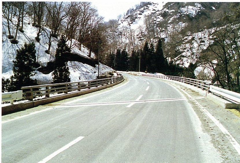
冬期間も安心して通れる二車線の道路となった。
