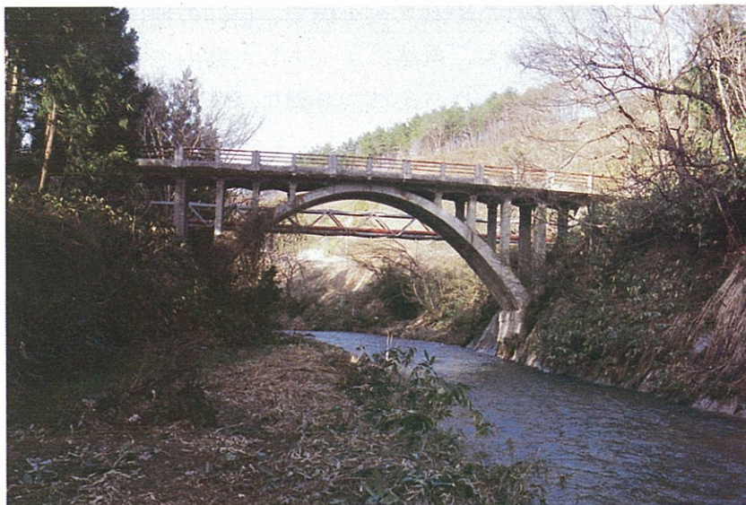
昭和5年に架設された旧橋。不動川に美しいRCアーチの姿を映し出している。昭和初期は美しい溪谷にさかんに架けられたRCアーチ橋も、少しずつその姿は消えつつある。
