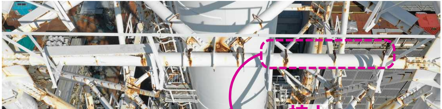
【写真⑨】 地上約76mの南側水平材
