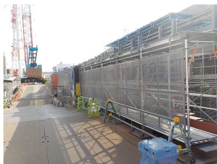
1/2号機排気筒：西側
