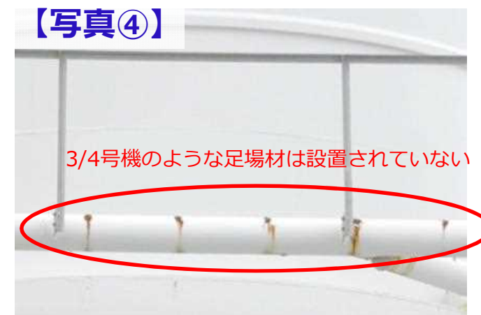
5/6号機の水平材 (鉄塔) 南面 地上76m付近
