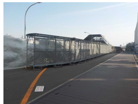
タービン建屋集中排気筒：東側
