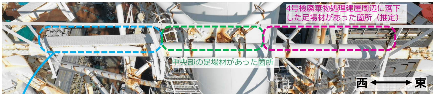
【写真⑪】 地上約76mの南側水平材 (再掲)
