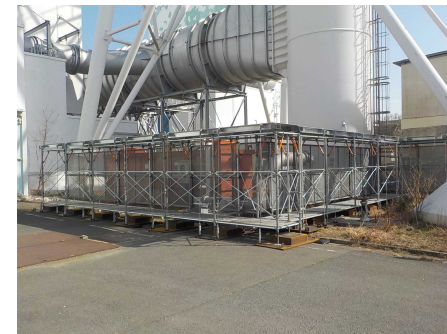
5/6号機排気筒：北側
