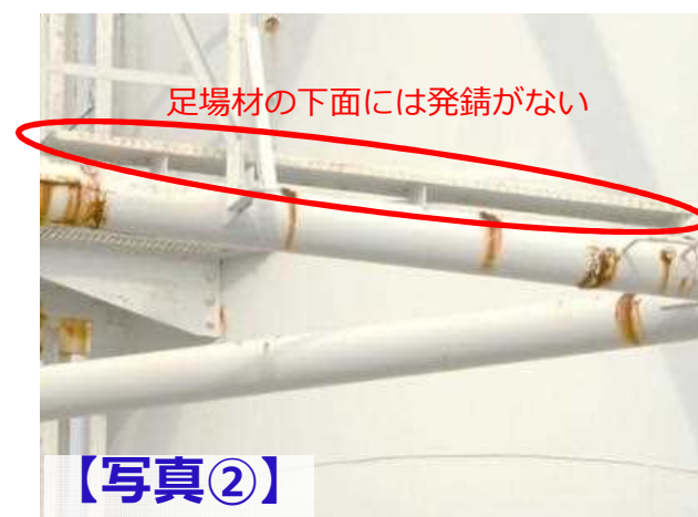
3/4号機 健全と推定される足場材 南面 地上67m付近
