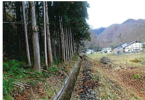
緩衝帯整備の様子（施工後）
