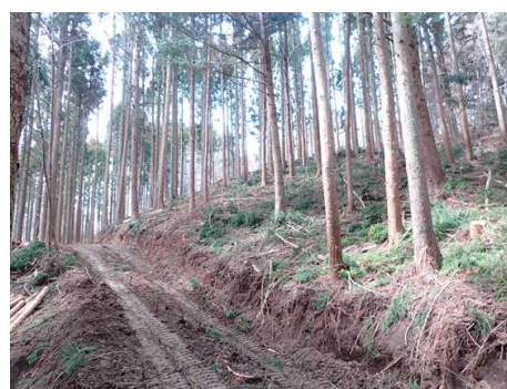
作業路の整備
