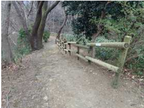
木製柵の設置（いわき市）
