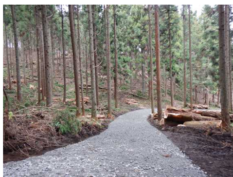
作業道の開設状況 (小野町)
