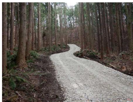
作業道の開設状況 (天栄村)
