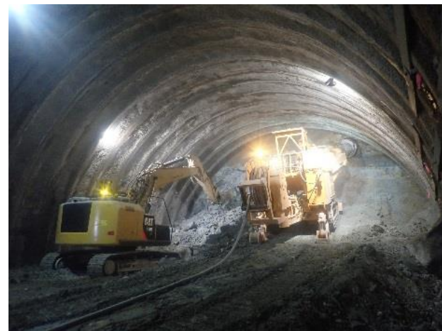
(仮称)田代トンネル
