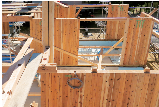
パネルログ工法による現場施工
