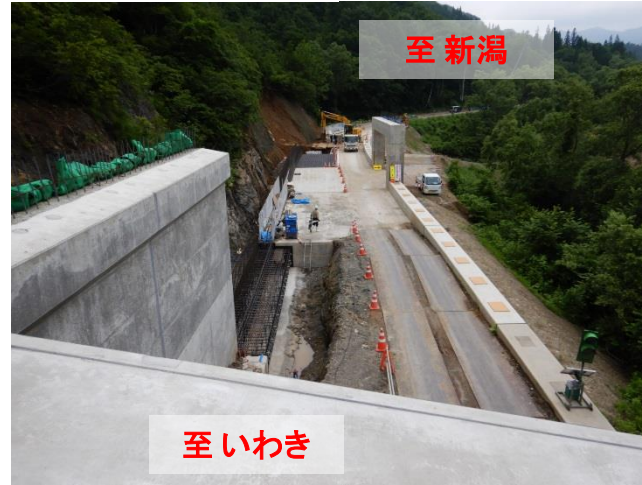
スノーシート工事状況
