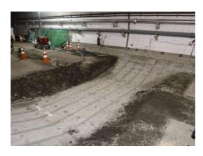
プレキャストインバートの設置は7月10日の夜に完了 して、現在は、工事をするために掘り下げた道路を、も との高さに復旧しています。
