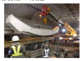
プレキャストインバートの設置が完了しました。 これにより、より強いトンネルへと生まれ変わりました。 インバート撤去に使用した機械が役目を終えて帰っていき ました。2年間お疲れ様でした。
