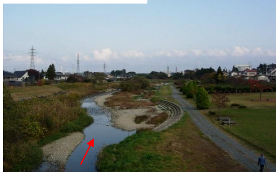
② 水無川の改修状況 (水道橋より下流)
