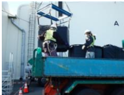
輸送車両への廃棄物積込状況
