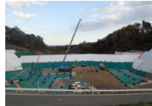
埋立処分施設の状況
