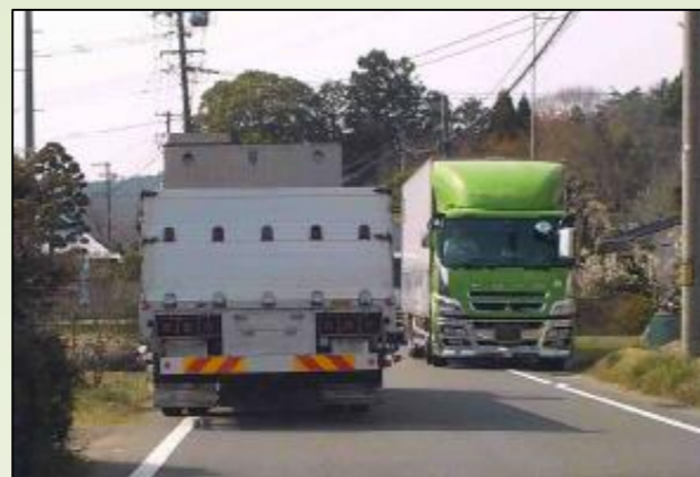
道幅が狭く大型車のすれ違いが困難
