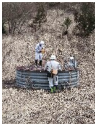
集水井の点検状況
