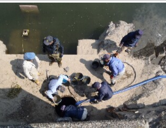
金沢地区揚水の取水口土砂上げ
