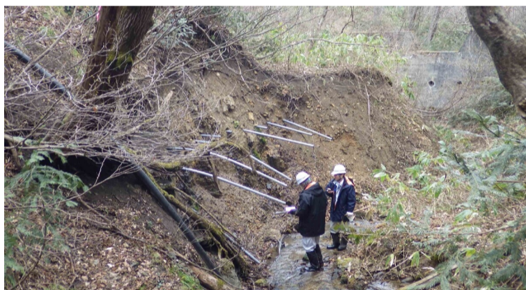
横穴ボーリングの点検状況
