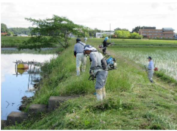
ため池堤体の除草状況(R1.6月中旬)
