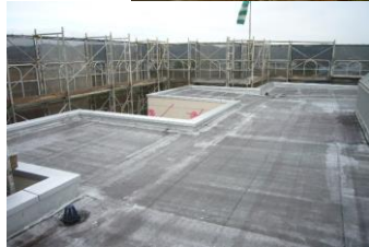
施工状況(屋上防水改修)
