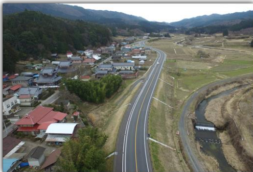
矢祭町(国道349号) 下関バイパス整備
