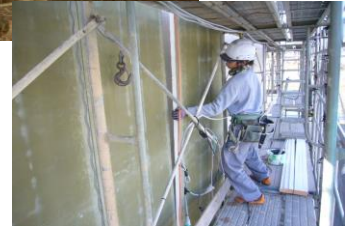
施工状況(外断熱)
