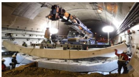
国道289号(甲子トンネル)
