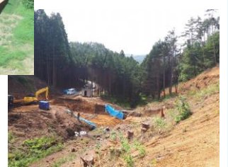
2号えん堤(施工状況)
