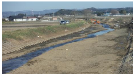
社川(河道掘削)
