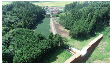
1号えん堤(完了)
