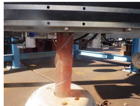
写真：落下防止ワイヤー
