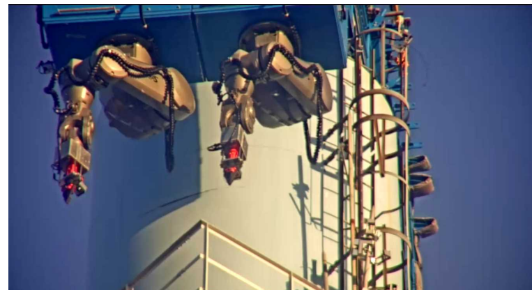
【写真⑥】 筒身切断状況 (9月18日)
