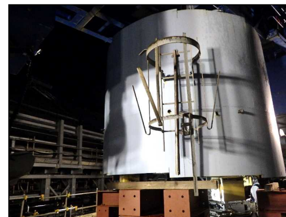
【写真④】吊り下ろし後 (10月22日)
