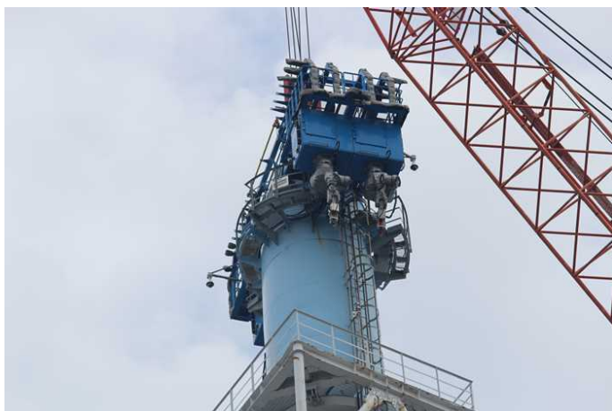
【写真①】切断作業状況・外側(9月1日)
