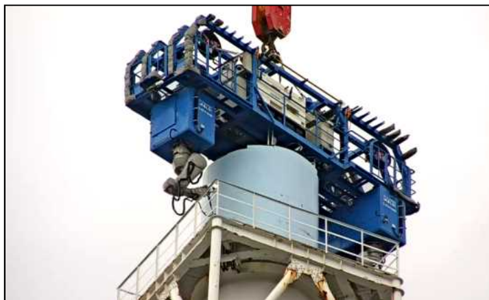
【写真①】筒身切断状況(10月8日)
