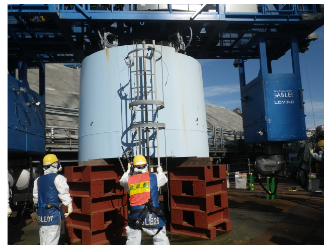
【写真⑧】 吊り下ろし後 (9月26日)
