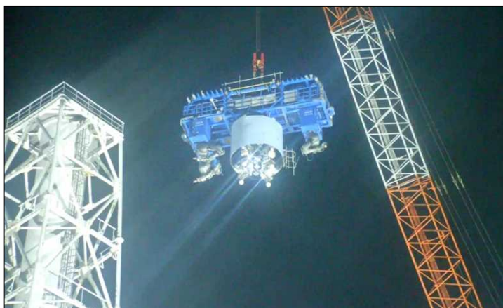
【写真③】吊り下ろし状況(10月22日)
