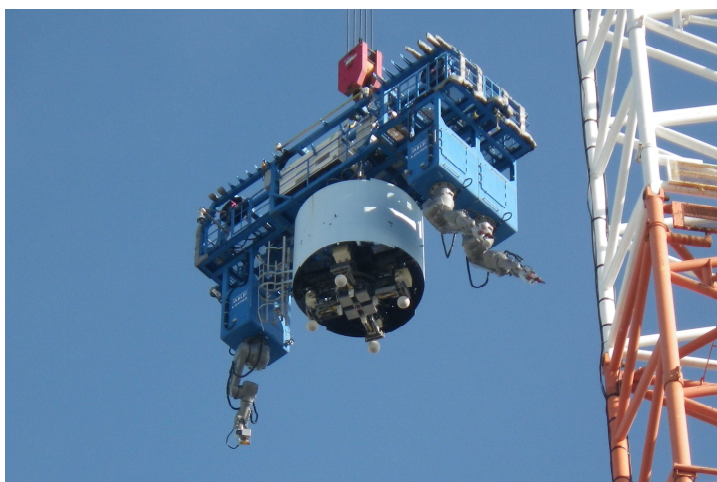
【写真⑦】 吊り下ろし状況(9月26日)
