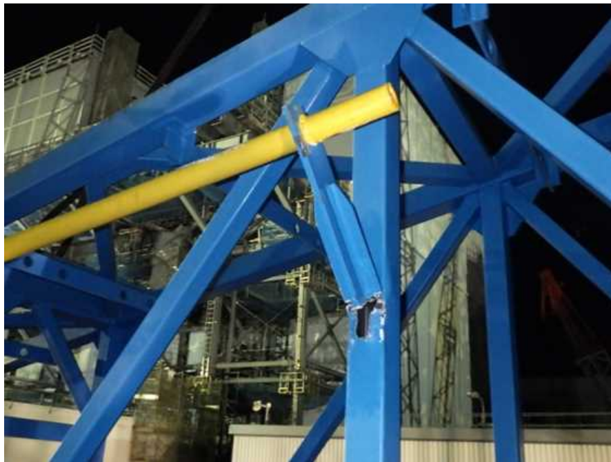
【鉄塔解体装置フレーム状況】
