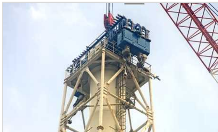
【写真①】筒身切断状況(10月27日)
