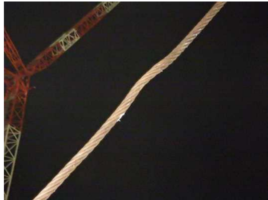
【鉄塔解体装置吊りワイヤー状況】
