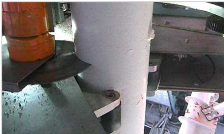
【写真③】斜材切断状況(11月7日)
