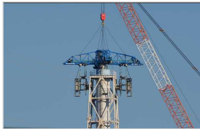
【写真②】斜材切断状況(11月6日)
