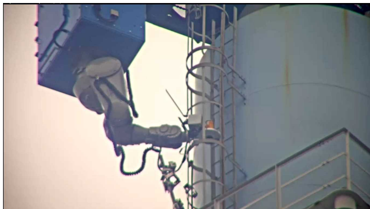
【写真⑤】 付属品切断状況(9月18日)
