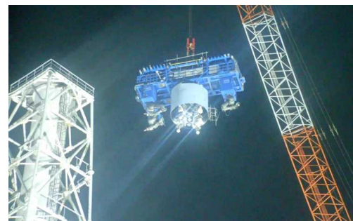
【写真③】吊り下ろし状況(10月22日)
