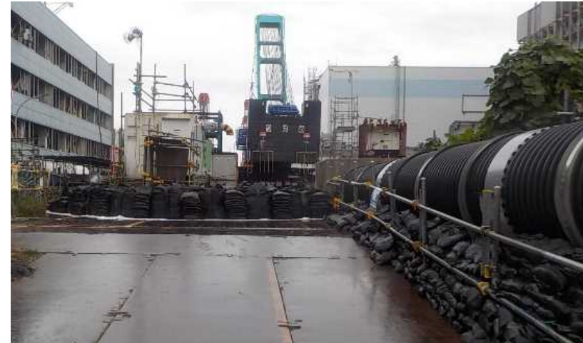
大型土嚢設置状況
