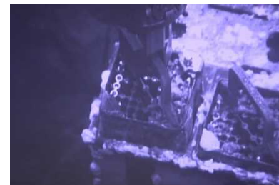
使用済燃料プール内にある 燃料集合体引き抜き状況
