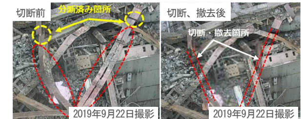
屋根鉄骨切断状況
