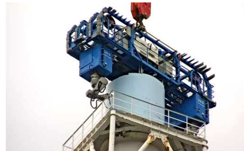
【写真①】筒身切断状況(10月8日)
