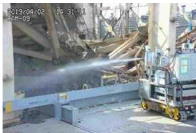
飛散防止剤局所散水状況
