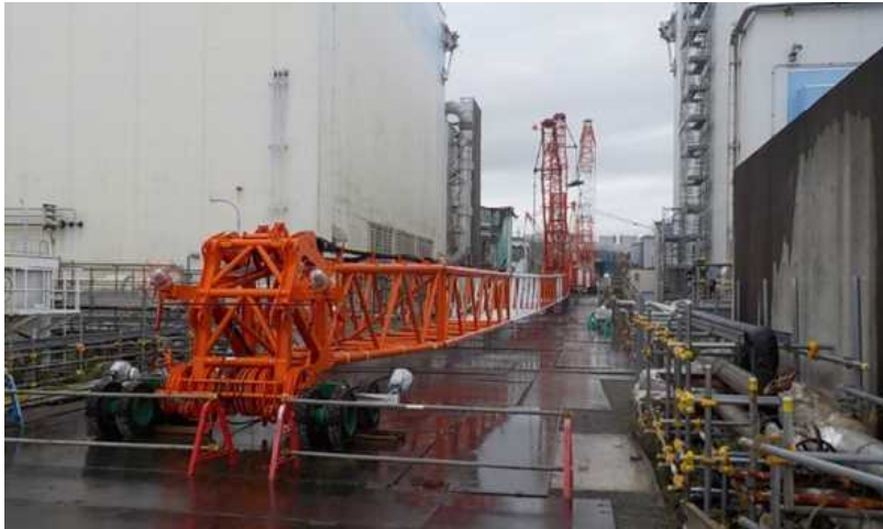
クレーンのブーム伏せ状況
