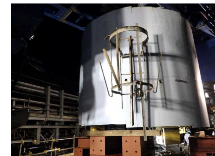
【写真④】吊り下ろし後(10月22日)
