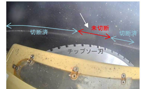
【写真②】筒身切断(マシン切)状況(10月21日)
