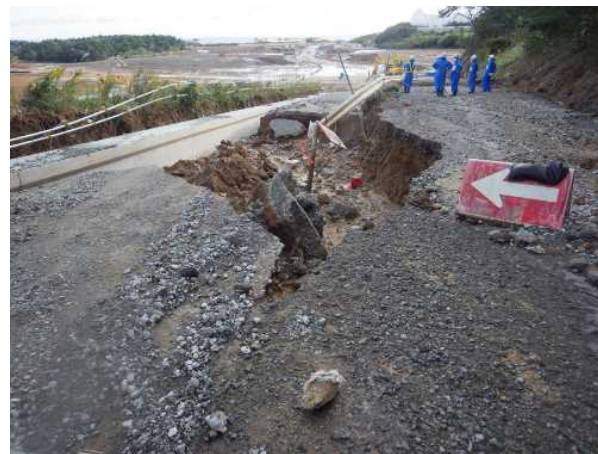
①第二土捨場北構内道路
