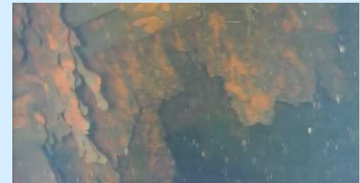
ペDESTAL内側の状況
