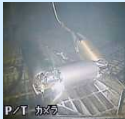
1号機調査装置
