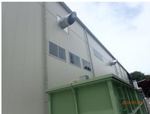
排気口の設置場所の確認
