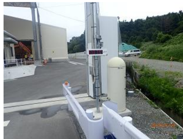
第二保管施設設置モニタリングポストの確認
