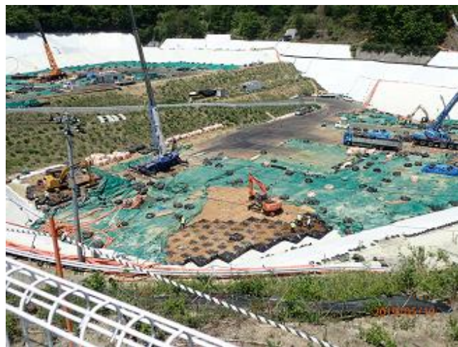
下流側埋立地の埋立状況の確認
