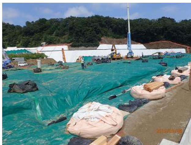
下流側埋立地の埋立状況の確認
