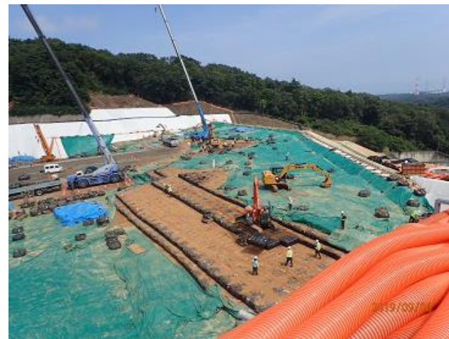
下流側埋立地の埋立状況の確認
