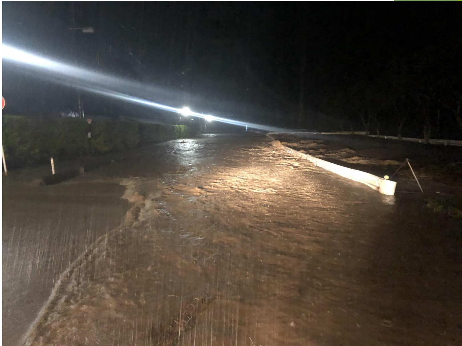
国道288号（田村市都路町岩井沢付近）
