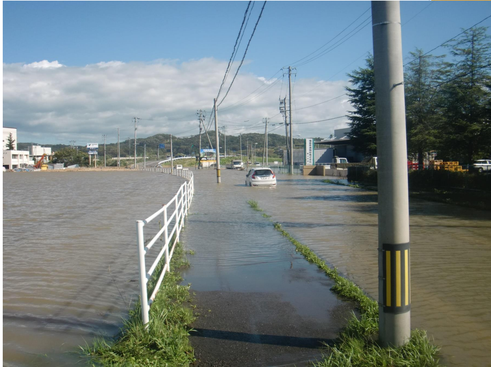
国道288号（郡山市富久山町福原付近）
