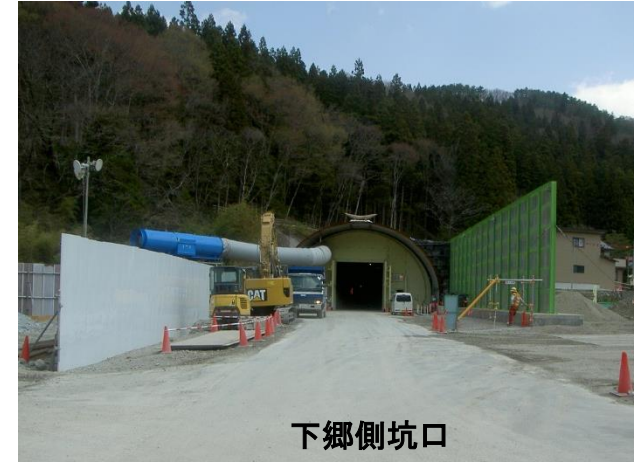
(仮称)田代トンネル
