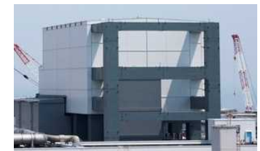
4号機原子炉建屋外観
