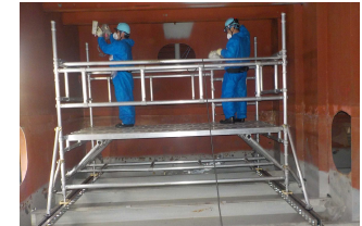
内部除染状況
