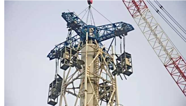
8ブロック目鉄塔解体作業(1月15日)
