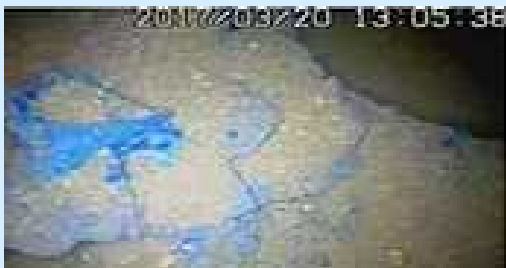
ペDESTAL外側の状況
