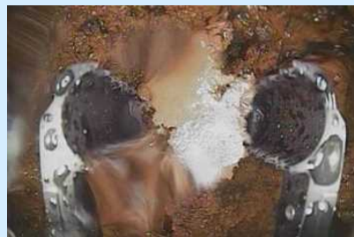
ペDESTAL内堆積物の把持状況
