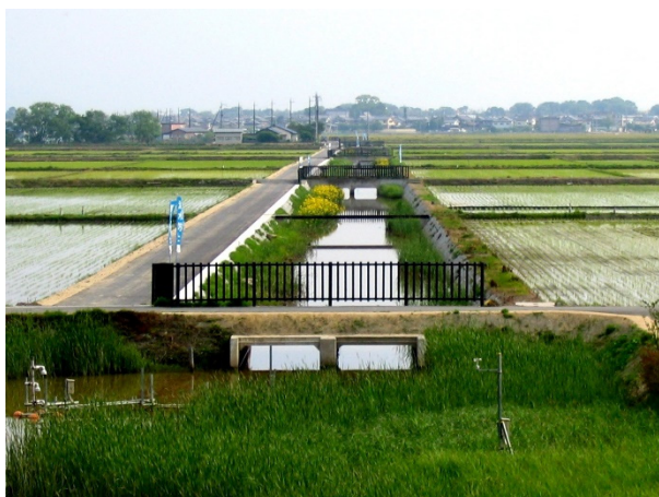
写真-15.15 多自然型排水路設置状況
