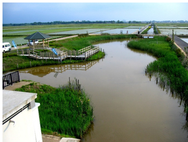
写真-15.16 多自然型浄化池設置状況
