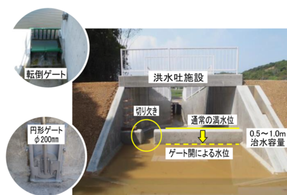
図-16.9 洪水吐放流ゲート等の設置
