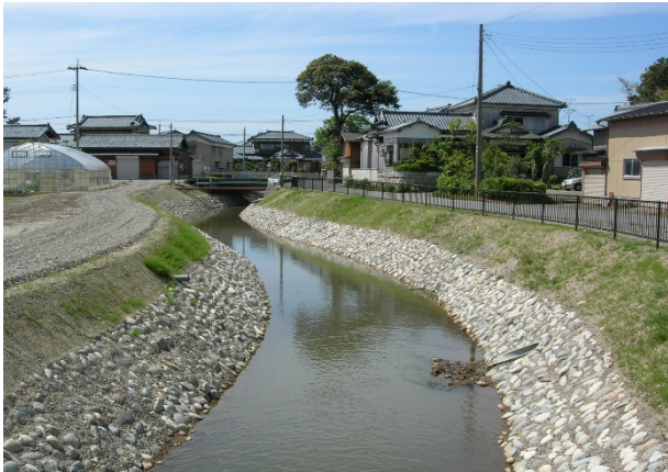
写真-15.13 緩勾配型自然石付金網護岸工設置状況
