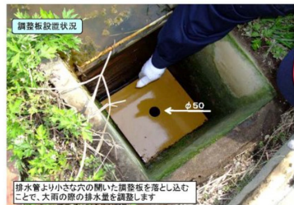
写真-16.1 調整板設置状況
