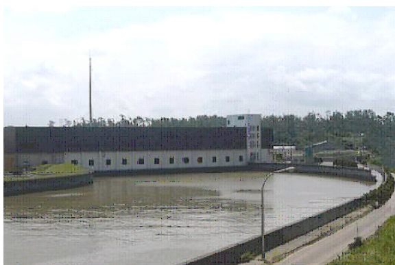
写真-15.6 事業実施前の排水機場
