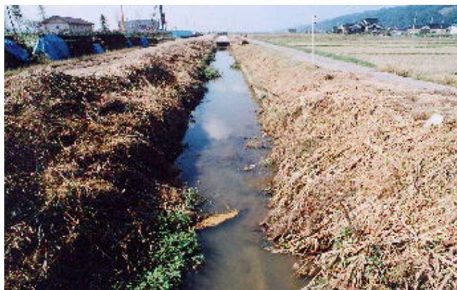
写真-15.4 事業実施前の排水路
