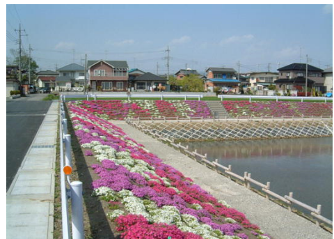
写真-15.8 地域住民参加で行われた遊水池法面の芝桜の植栽
