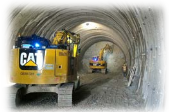
道路(トンネル)工事
