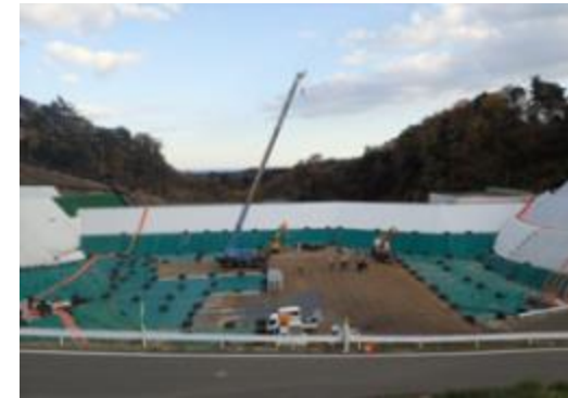
埋立処分施設の状況
