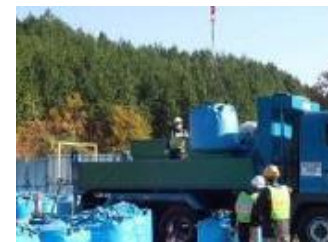
除去土壌等の車両積込状況
