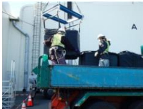
輸送車両への廃棄物積込状況
