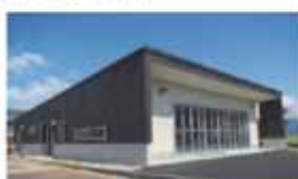
猪苗代水環境センター （猪苗代町）
